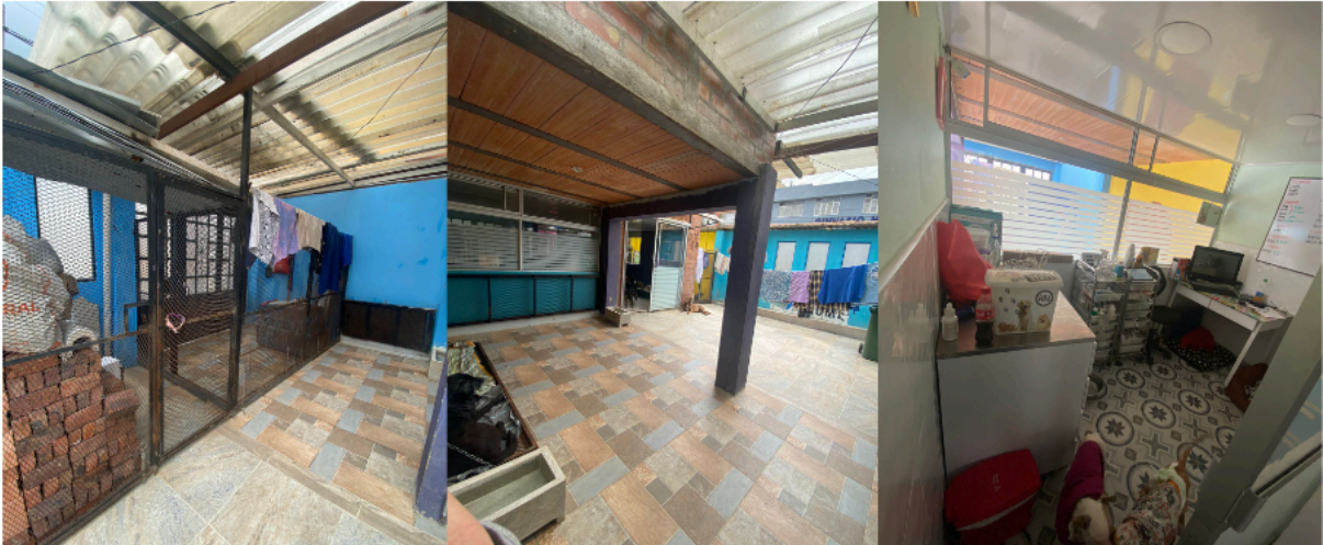
Primer piso. Remodelación zona de acceso a la Fundación, zona recreativa y consultorio atención salud.
